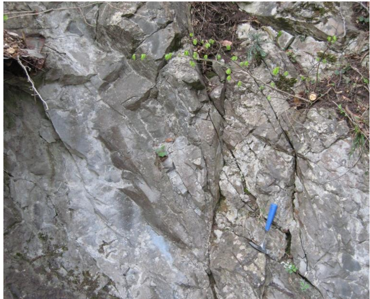
Felsaufschluss im Bereich des Lüftungsschachtes (Blasenberg)
