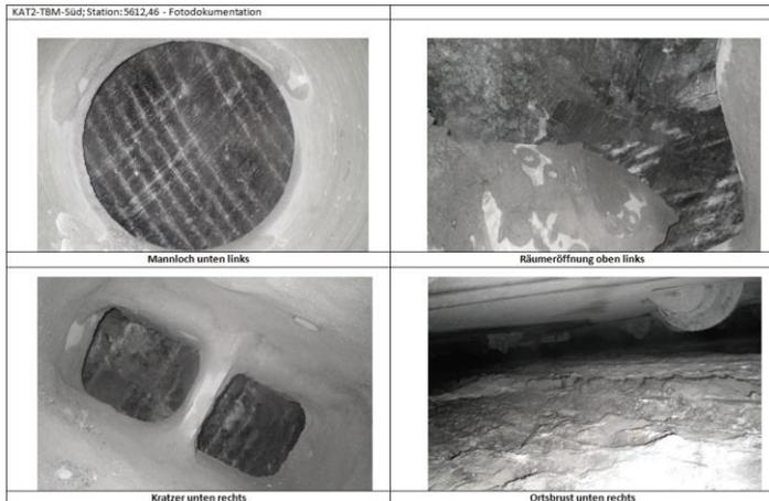
Fotodokumentation der Ortsbrust (im Bohrkopf der TVM) © 3G
